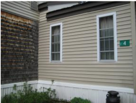
Non "mobile" Exterior siding
